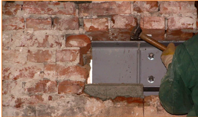
Fot. 6.4. Klinowanie górnych stopek nadproża przy użyciu stalowych blach
