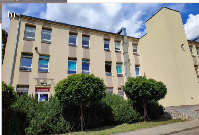
Fot. 3.1. Ogólny widok budynku „K” od strony południowo-wschodniej: a) dobudowany do pierwotnej bryły obiektu szyb windy towarowo-osobowej z wejściem do oddziału Kardiologii, b) wejście do oddziału Zakaźnego oraz dobudowany po 2009 r. szyb windy towarowo-osobowej
