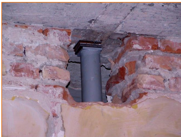
Fot. 6.1. Rozmieszczone równomiernie na długości projektowanego nadproża krótkie stalowe stemple, ustawione w osi ściany i wyklinowane przy użyciu różnej grubości stalowych blach
