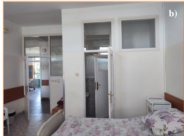
Fot. 3.7. Przewidziana do adaptacji na potrzeby Pracowni Elektrofizjologii sala chorych Nr 4: a) ogólny widok pomieszczenia od strony wejścia, b) widok węzła sanitarnego oraz ściany korytarzowej z wejściem
