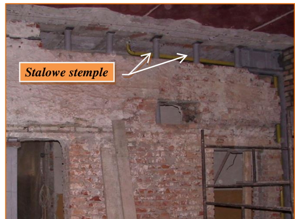
Fot. 6.1. Rozmieszczone równomiernie na długości projektowanego nadproża krótkie stalowe stemple, ustawione w osi ściany i wyklinowane przy użyciu różnej grubości stalowych blach
