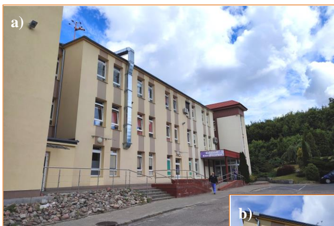
Fot. 3.1. Ogólny widok budynku „K” od strony południowo-wschodniej: a) dobudowany do pierwotnej bryły obiektu szyb windy towarowo-osobowej z wejściem do oddziału Kardiologii, b) wejście do oddziału Zakaźnego oraz dobudowany po 2009 r. szyb windy towarowo-osobowej
