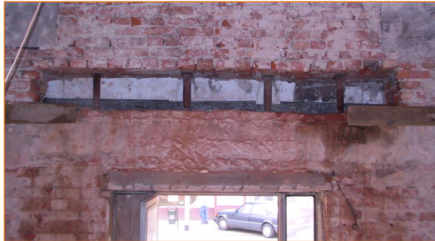
Fot. 6.2. Przelotowe przekucie ściany, w którym rozprężne lub zwykłe stalowe stemple przekazują obciążenie z górnej partii ściany na jej dolną część
